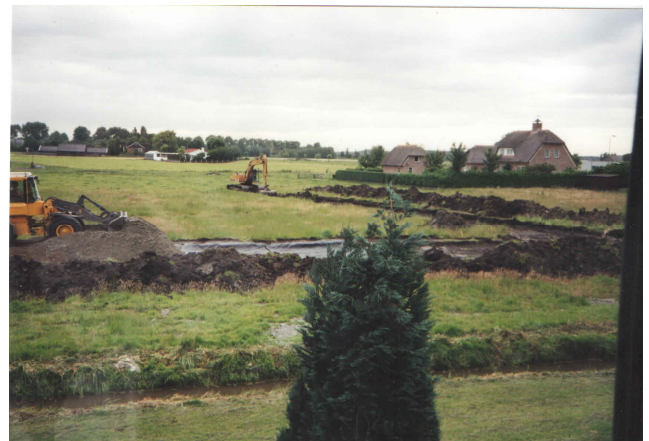
De bouw begon met de aanleg van een werkweg, later omgebouwd tot het huidige fietspad. Deze foto is uit 1999.
