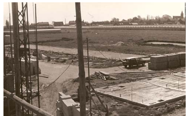
Start van de bouw in Vrouwjesland. Foto Ninon Vis
